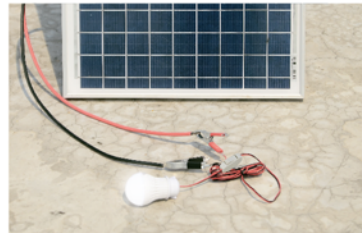
4 ไฟติดแล้วครับ ไฟที่ผลิตจากแผงโซล่าเซลล์
