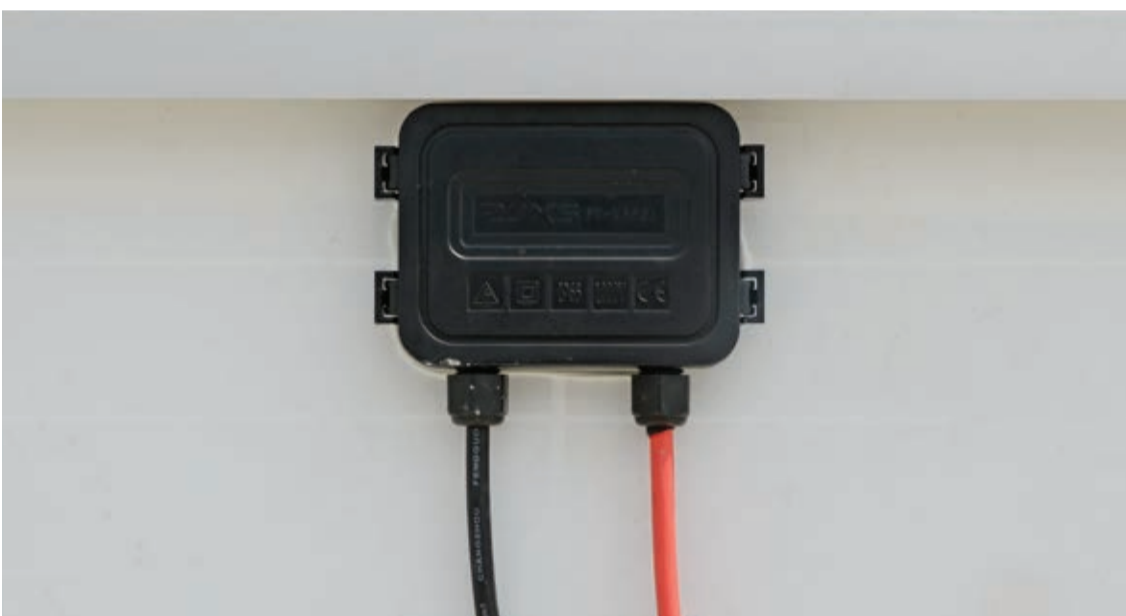
3 จังชันบ็อกซ์ และสายไฟ
